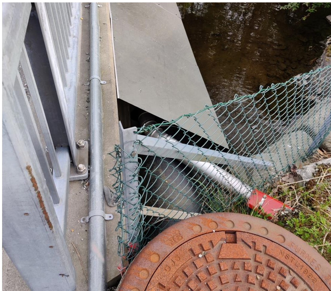
Bilde 4: Eksisterende bruoppeng for vannledning over Dalelva.
